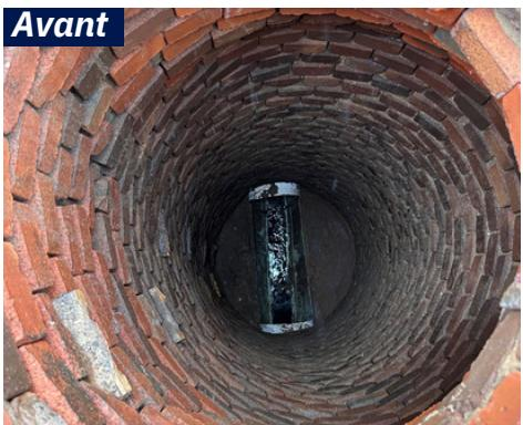
GeoKrete RS est un géopolymère breveté, renforcé de fibres et mélangé en usine, amélioré par un agrégat de quartz monocristallin. Il offre une protection anticorrosion dans les environnements à forte teneur en sulfure d'hydrogène (H<sub>2</sub>S), augmente l'intégrité structurelle et empêche l'infiltration des eaux souterraines dans les structures détériorées.
