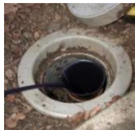
Insérer le manchon dans le tuyau de nettoyage
