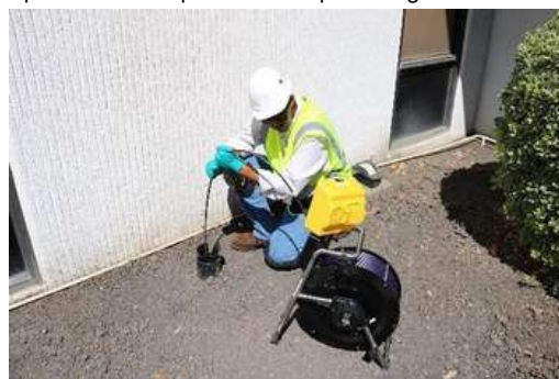
Une mise en place et une poussée incorrectes peuvent entraîner le pliage de la tige de poussée.
